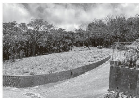
▶西部プラザ公園西側整備工事 予定箇所
