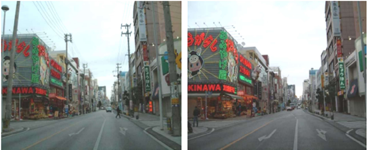
写真一2 国際通り(那覇市)の整備前後の状況(左:整備前、右:整備後) [出典:沖縄県無電柱化推進計画(令和4年3月沖縄県土木建築部)]
