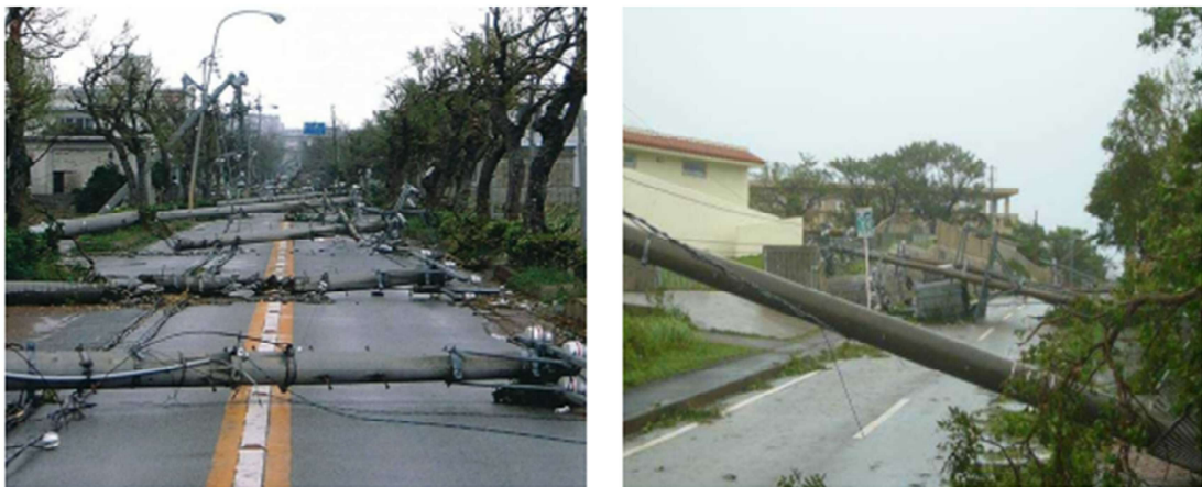
写真－1 台風による電柱倒壊状況
