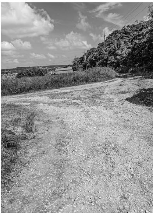
▲八重瀬町第3地区土地改良区②
