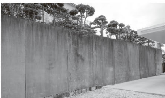
▶ 11街区の水抜き穴が殆どない擁壁
