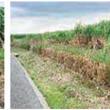
ベチバー植付けによる赤土流出防止
