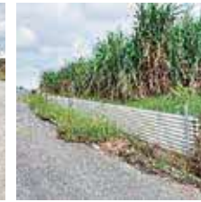
トタンによる土留め
