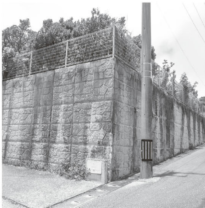
▲富盛地区擁壁
