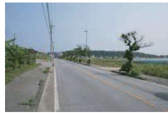
国道507号 具志頭地域
