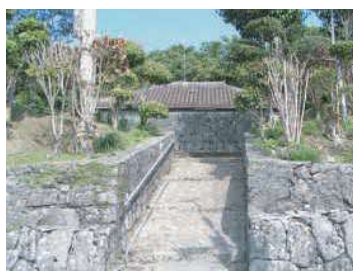
石垣とフクギ屋敷林に囲まれた赤瓦住宅（字東風平）
