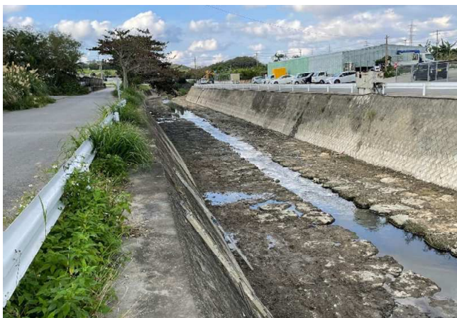
(饒波川：一部浚渫工事完了)
