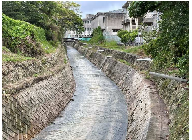
(報得川：東風平中学校付近、一部工事完了)
