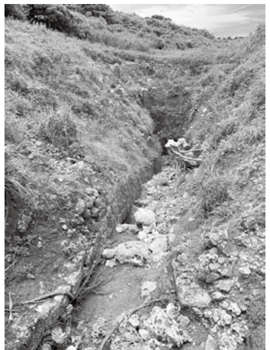
石組みの崩壊が進む慶座
