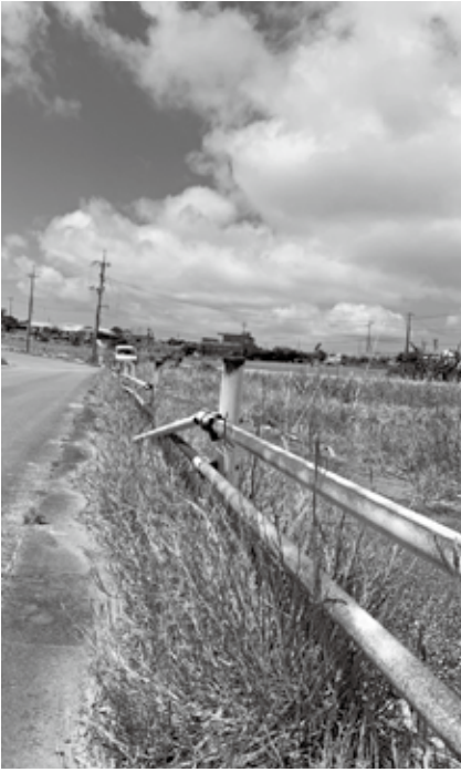
町道白川線安全対策
