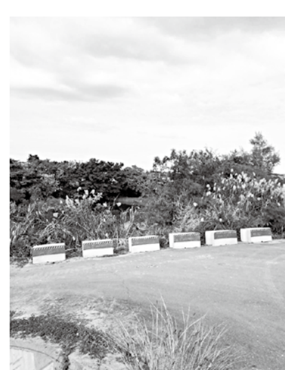
トンブロックを設置
