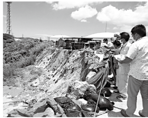
上田原飲屋隣接地の土砂崩れ現場
