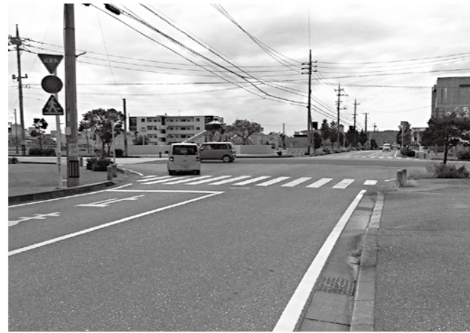
早急な信号機設置が望まれる屋宜原中央公民館付近の交差点
