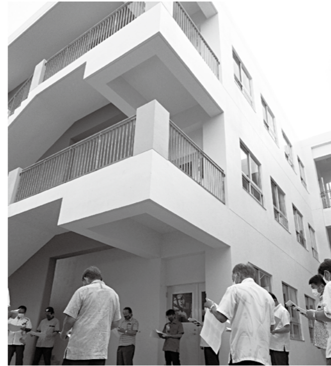
完成した白川小学校地上3階建校舎
