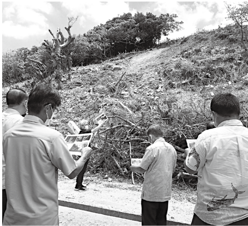
破名城土地改良区の土砂崩れ現場
