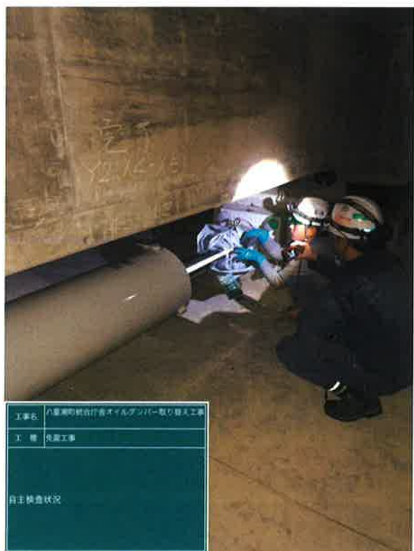
⑧オイルダンパー取替完了自主検査
