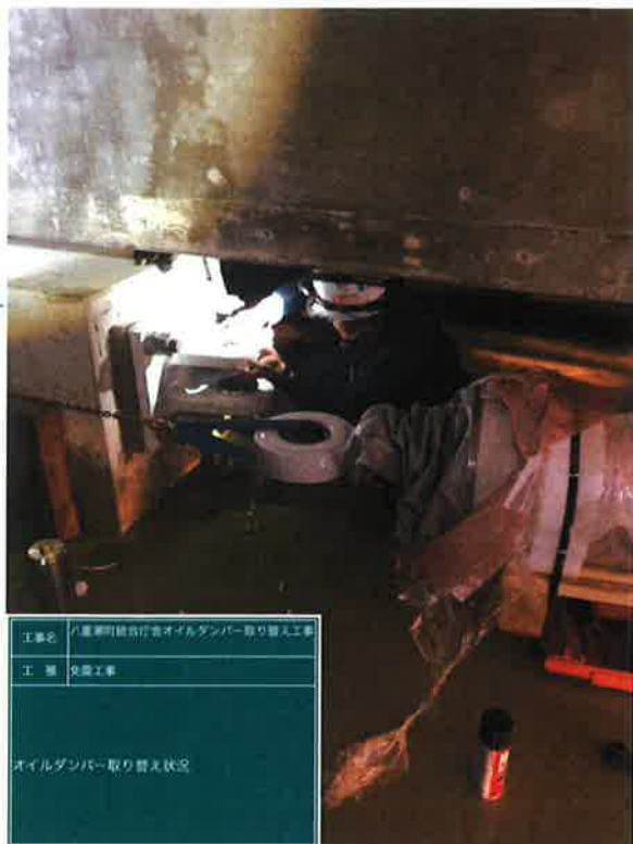
⑧オイルダンパー取替完了自主検査
