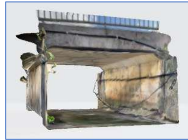
写真-3 橋梁内空を3D化した画像
