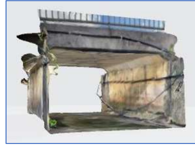
写真-3 橋梁内空を3D化した画像
