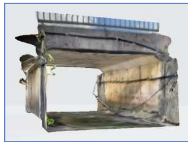
写真-3 橋梁内空を3D化した画像
