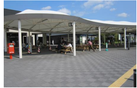
事例：友部 SA 屋根付き広場 (茨城県笠間市)
