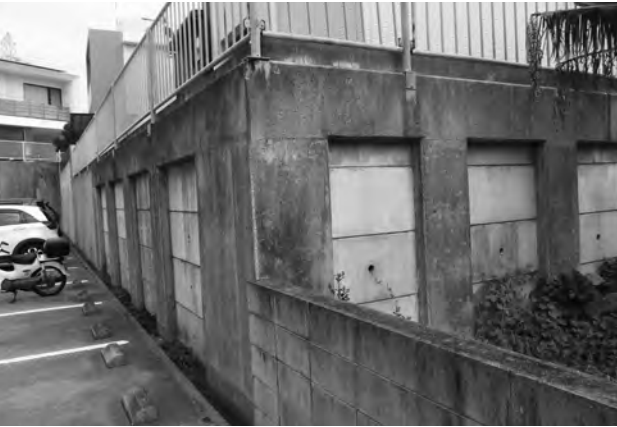
区画整理事業内の自立式擁壁 (角地の自立式擁壁)
