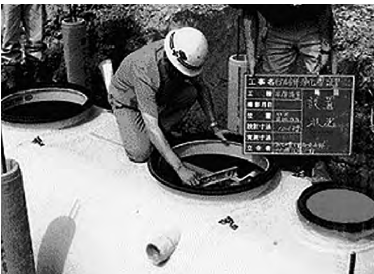
浄化槽設置工事
