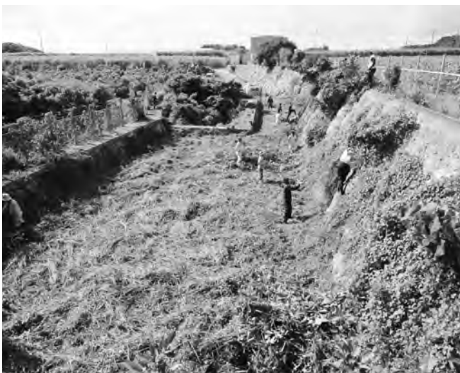
沈砂池8号の作業風景 (令和5年7月撮影)
