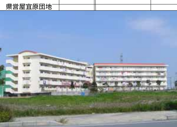
県営屋宜原団地
