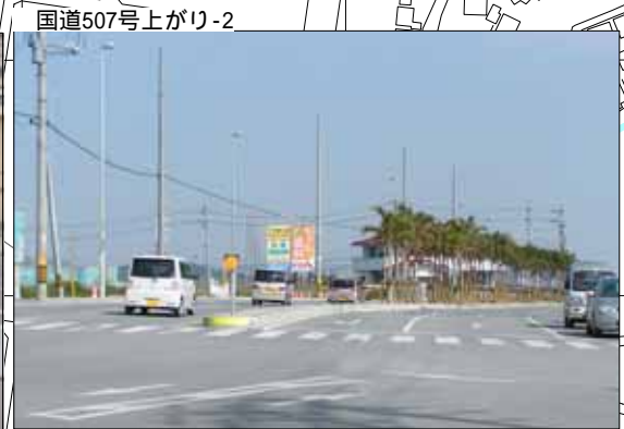
国道507号上がり-2
