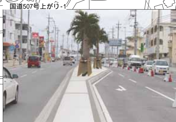
国道507号上がり-1
