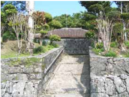
【石垣とフクギ屋敷林に囲まれた赤瓦住宅（字東風平）】
