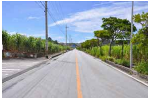
【国道 507 号 (具志頭地域)】
